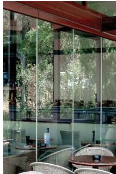
ガラス間は、ポリカーボネートまたは PVCの耐候性プロファイル
