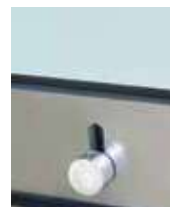
ロックボルト(室内)
