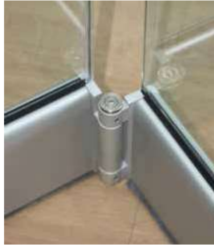
パネル間のアルミ製ヒンジ
