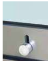
ロックボルト(室内)
